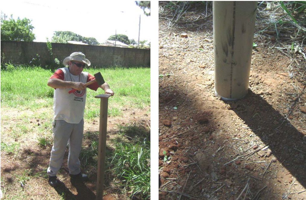
Figura 3 - Cravação do revestimento do tubo de PVC.
