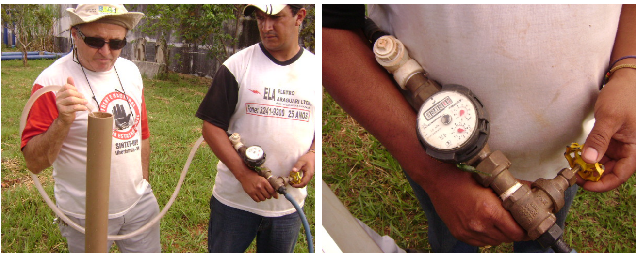
Figura 5 - Controle da vazão constante, realizada por hidrômetro.
