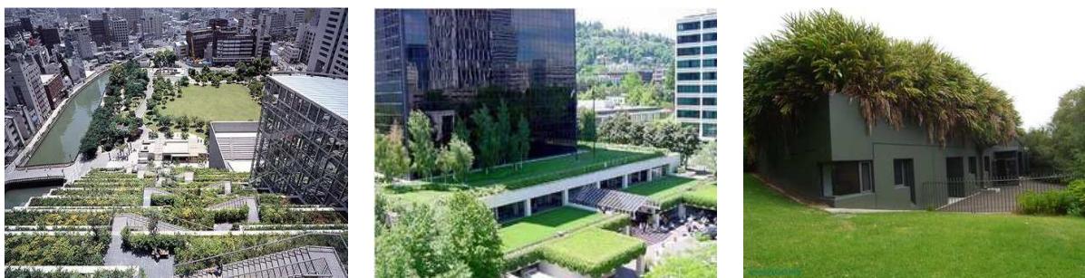
Figura 7 – Exemplos de telhados intensivos.
