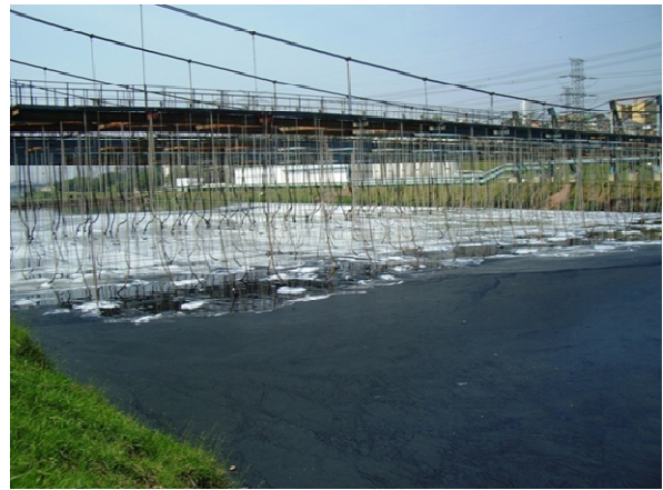
Figura 5 – Injeção de ar dissolvido e flotação
