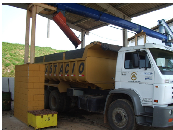
Figura 9– Carregamento do lodo desidratado
