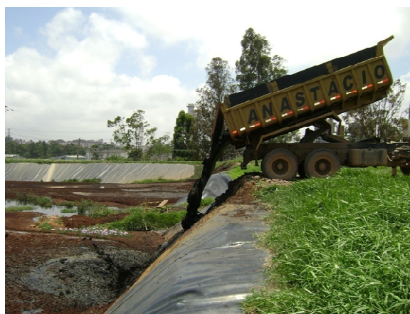
Figura 10– Lançamento do lodo no bota fora
