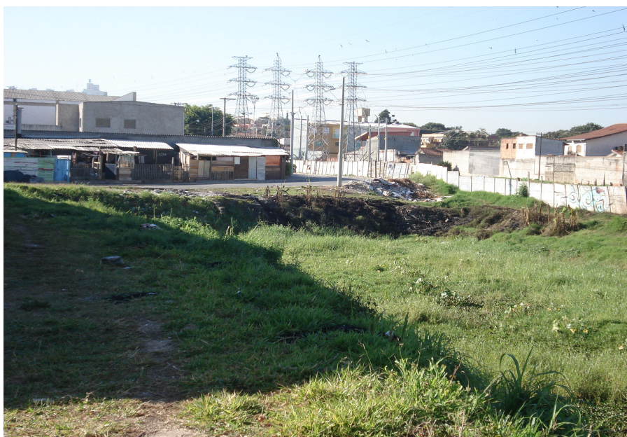
Figura 1 – Vista parcial do Reservatório de Detenção de Cheia Urbana “Bom Pastor”
