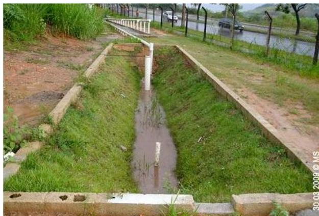
Figura 7 – Configuração final da vala de detenção (vista de jusante para montante).
