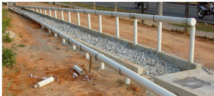
Figura 6 – Configuração final da trincheira de infiltração (vista de jusante para montante)
