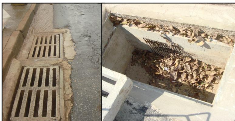
Figura 3 – Captação de água pela boca de lobo (esquerda), acúmulo de sedimentos (direita)
