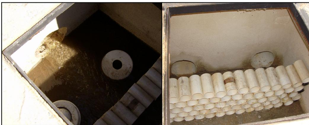
Figura 4 – Caixa de passagem: entrada e amostragem a montante (esquerda), saída e tranquilizador de escoamento (direita)
