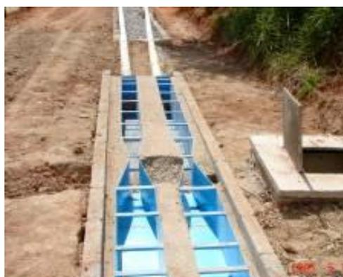
Figura 5 – Sistema com calha Parshall para medição da vazão afluente
