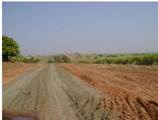
Figura 13 – Foto da colocação de revestimento primário utilizado na estrada PSP-428.
