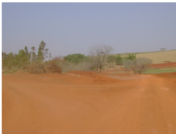
Figura 14.b – Foto de entrada de uma propriedade, após as obras de adequação (31/08/2007).
