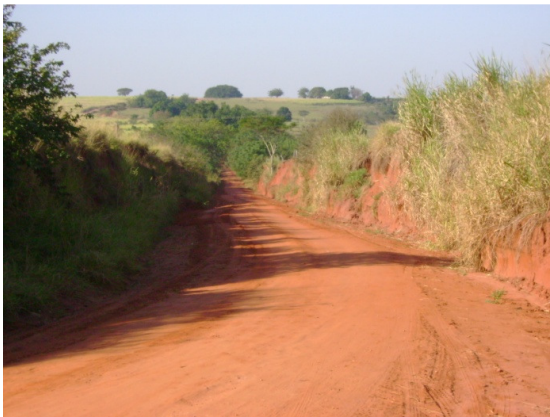
Figura 7 - Barrancos muito altos, estrada larga e rampa comprida, facilitando o acúmulo de água e intensificando os processos erosivos (06/06/2007).
