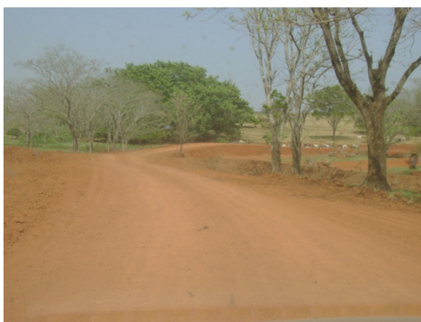
Figura 15.b – Foto de um trecho da estrada PSP-428, após as obras de adequação (31/08/2007).
