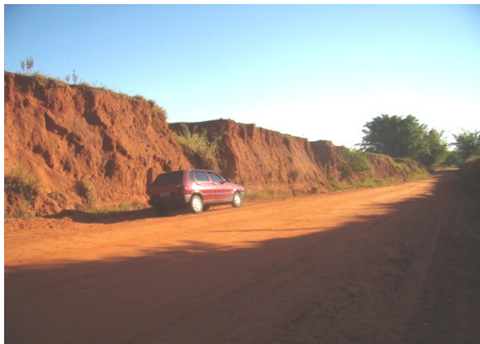
Figura 4 - Foto da estrada antes da obra de adequação totalmente encaixada e barrancos com aproximadamente 5 metros de altura (29/06/2007).
