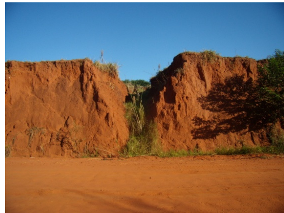
Figura 8 - Foto de um processo erosivo ocasionado pelo mau escoamento de águas pluviais que, a partir de uma propriedade rural, caem na estrada (29/06/2007).
