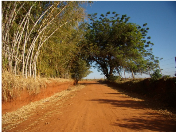
Figura 15 – Foto do trecho onde há presença de bambu, antes das obras de adequação (29/06/2007).
