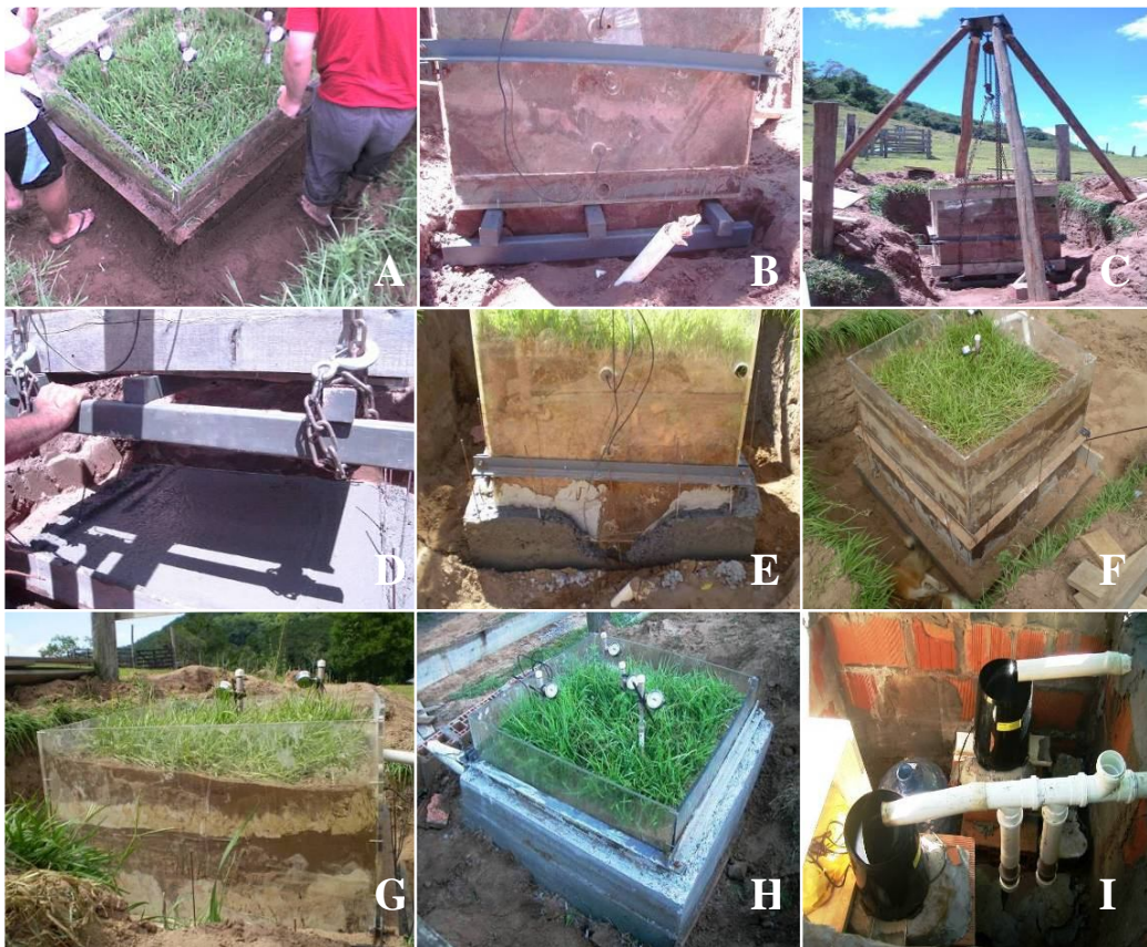
Figura 5 – Conserto do lisímetro instalado na sub-bacia Rancho do Amaral.
