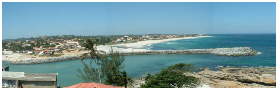
Figura 16.- Vista do molhe guia-corrente de berma – Saquarema, RJ
