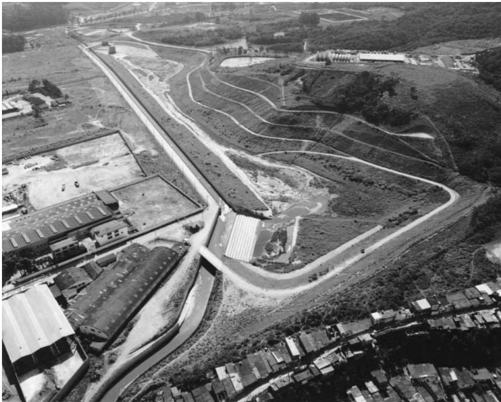
Figura 10: Reservatório de Detenção AT-3 – Mauá – São Paulo
