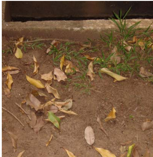
Figura 8 – Local de Inspeção de Vazamento Próximo ao Prédio do ICE-UNIFEI (2006).
