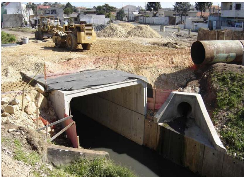
Figura 11 – Vista geral da galeria com a execução das contenções provisórias de encostas com tapumes de madeira.
