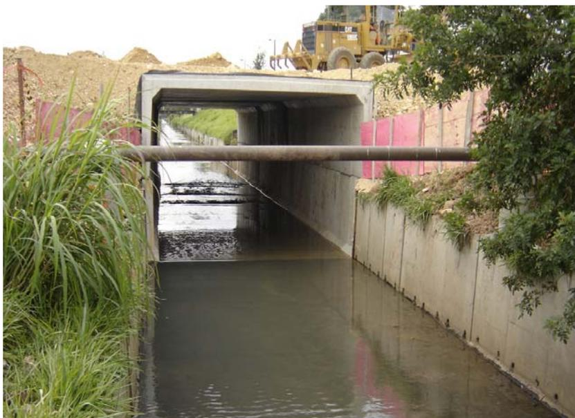
Figura 6 – Vista geral da galeria celular implantada, durante a fase final de execução dos aterros laterais
