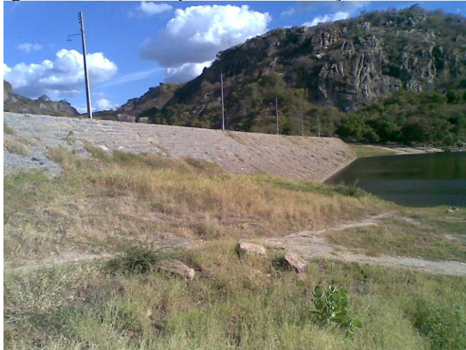
Figura 5 - Barragem auxiliar, com postes de iluminação sobre a crista da barragem.
