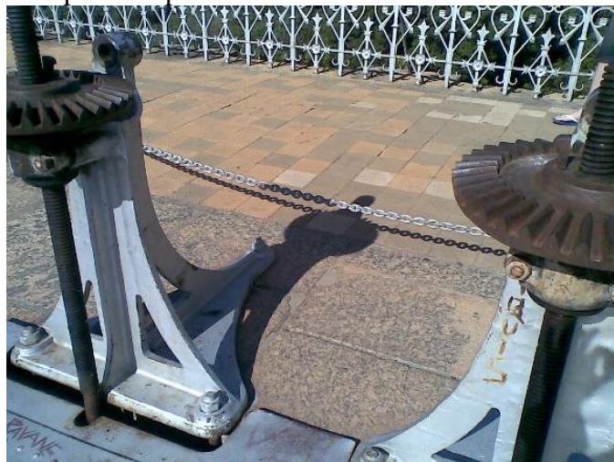
Figura 7 - Dispositivo para abrir ou fechar a válvula da tomada d'água.
