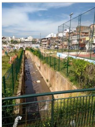
(a) Córrego do Jardim Letícia canalizado
