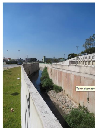
(b) Córrego do Ponte Baixa canalizado
