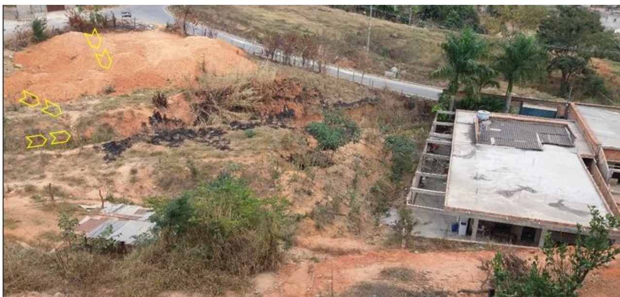
Figura 6 – Vista dos terrenos dos reclamantes
