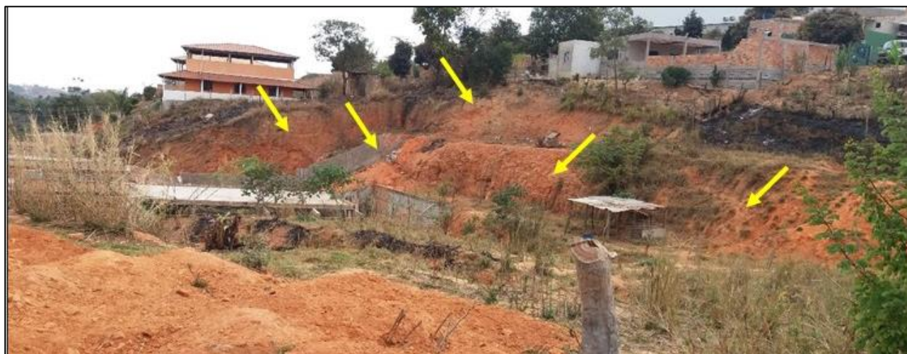
Figura 8 – Vista de corte e desmatamento dos terrenos
