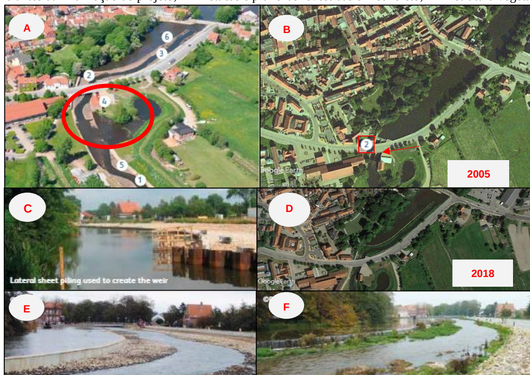
Figura 3.A – Indicação das intervenções executadas; B – Imagem de satélite 4 anos antes da intervenção e destaque para a estrutura da represa; C – Estacas e pranchas laterais usadas para criar o novo açude; D - Imagem de satélite da área 1 ano antes da finalização do projeto; E – Estacas e pranchas revestidas em concreto; F – Estrutura vegetada
