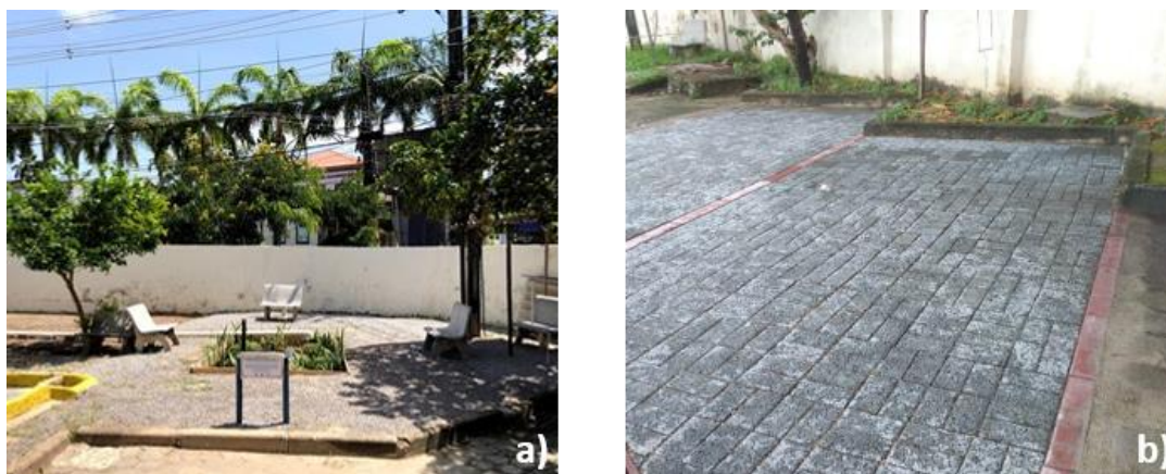
Figura 1 – Jardim de chuva: 2,00 x 3,00 m (a); e pavimento intertravado permeável em 2 vagas de estacionamento (b).
