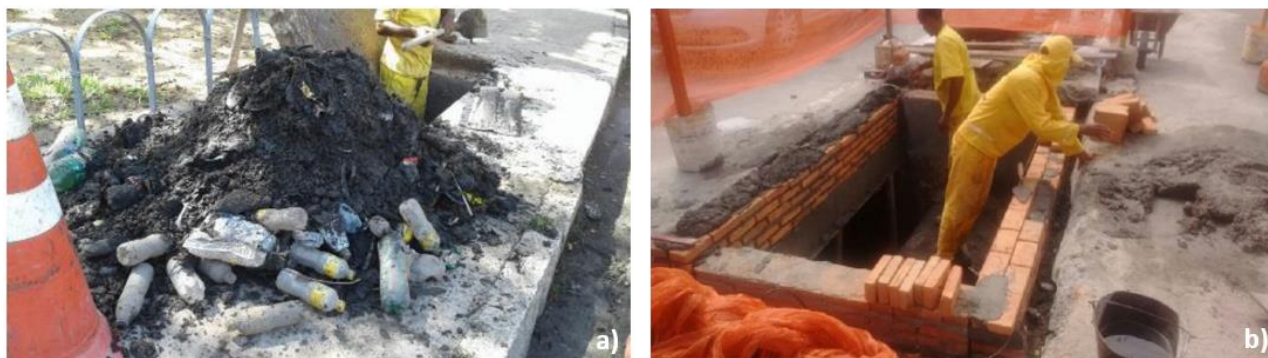
Figura 7 – Limpeza e desobstrução da rede (a) e construção de poço de visita (b).
