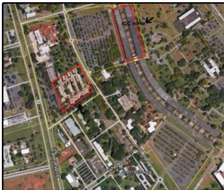
Figura 3 - Região da FT e ICC norte. (Fonte: Google Earth, 2019).
