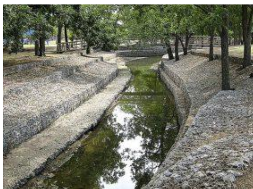
[a] Estabilização com muro vertical de gabião. Fonte: Maccaferri (2020)
