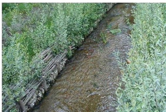
[b] Estabilização de margem de canal com esteira de ramos, técnica de Engenharia Natural. Fonte: Antão (2010)
