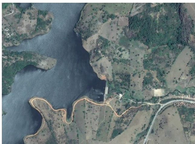
Figura 2 - Vista aérea da Barragem Pau Ferro, Quipapá – PE (Fonte: Google Earth (2019)).
