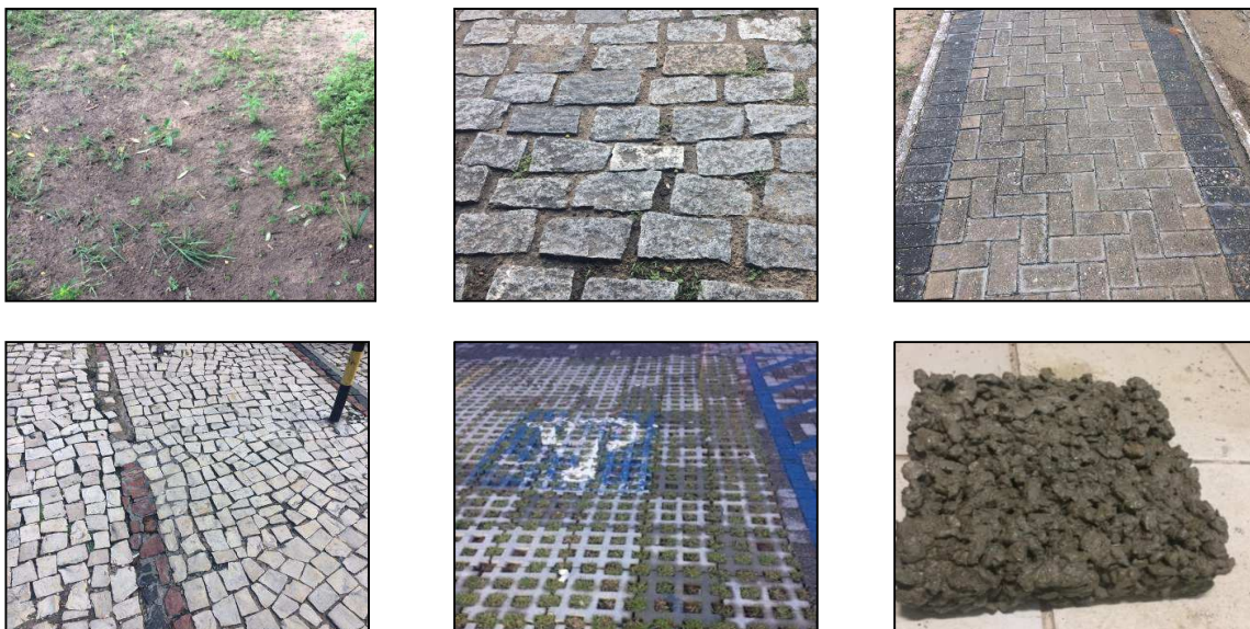
Figura 1 Tipos de pavimentos permeáveis
