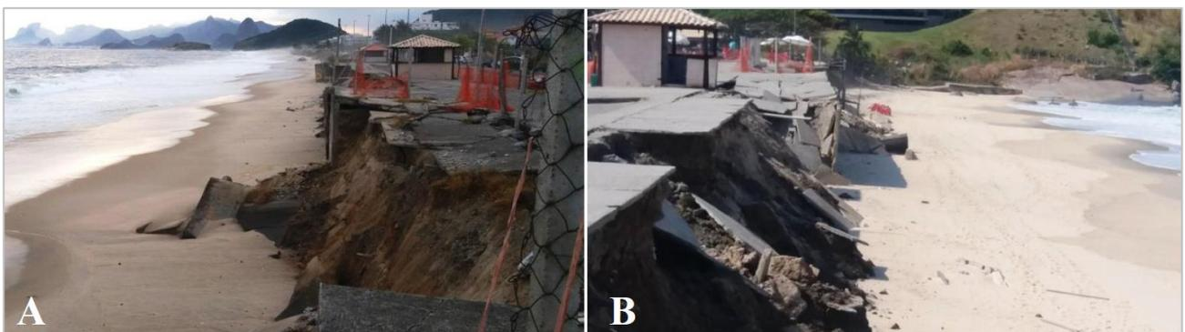
Figura 3: Erosão observada na Praia de Piratininga, Niterói - RJ, após a ocorrência de ressaca no ano de 2016. Fonte: Pereira et al. (2017).
