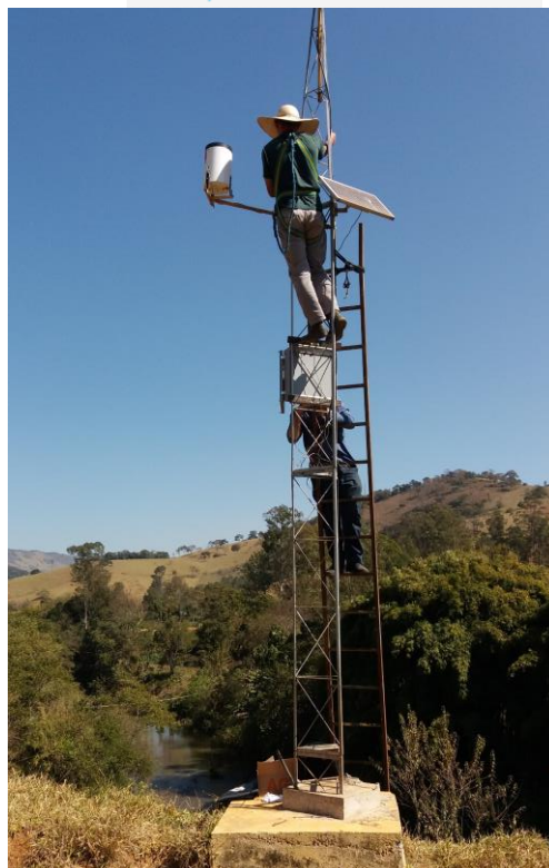
b) Estação São Pedro
