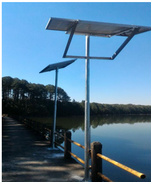
Figura 3: Instalação e posicionamento das placas solares na Barragem Pedro Beicht.
