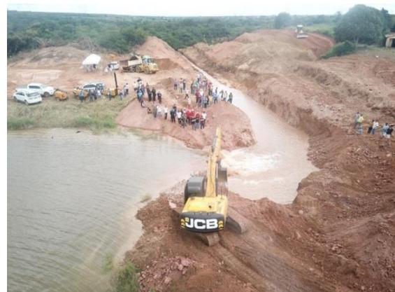
Figura 4: Escavação do vertedor auxiliar.
