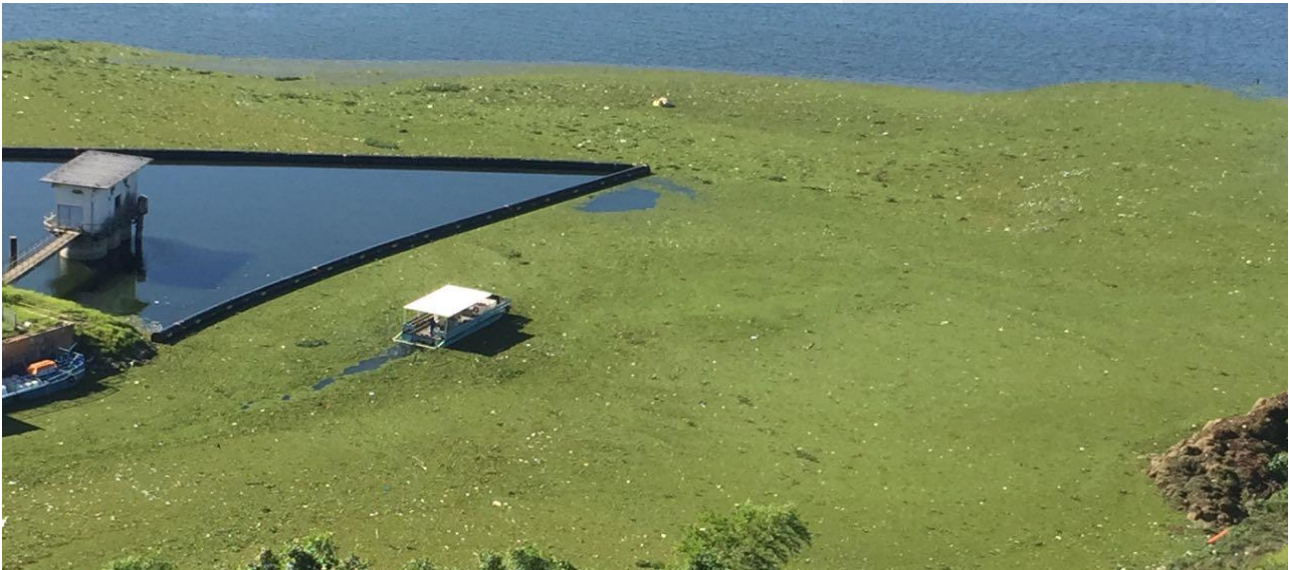
Figura 6 – Vista aérea da barreira de contenção Flutuante operando no manancial Guarapiranga.
