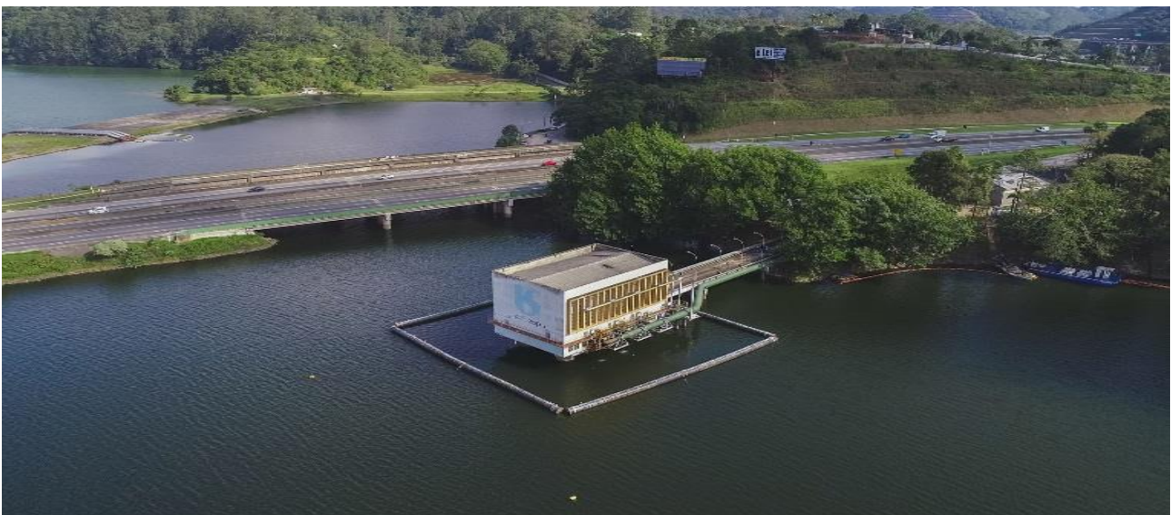
Figura 8 – Vista aérea da barreira de contenção Flutuante operando no manancial Rio Grande.
