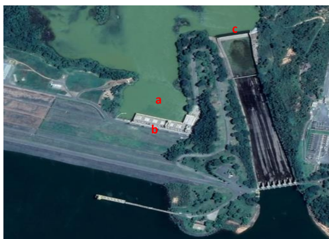
Figura 1- a) Canal de Fuga Barragem de Três Marias b) Turbinas c) Vertedouro (GOOGLE, 2019)
